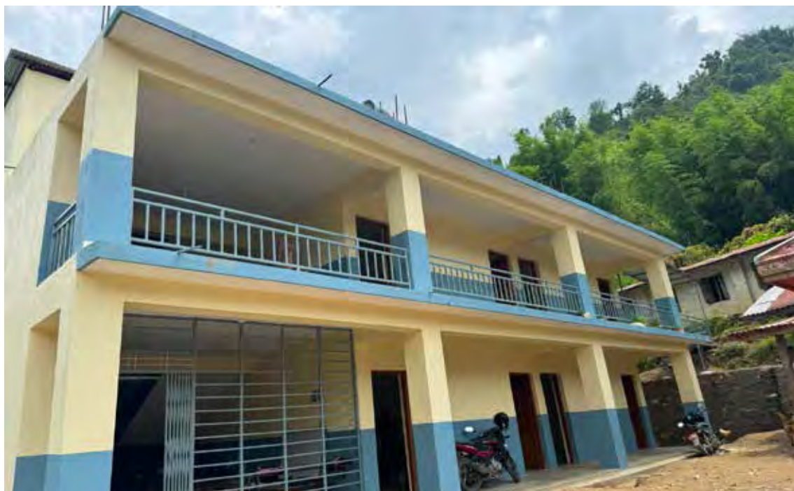
जनता मा.वि.सोरुङ छविसेको नवनिर्मित भवन
